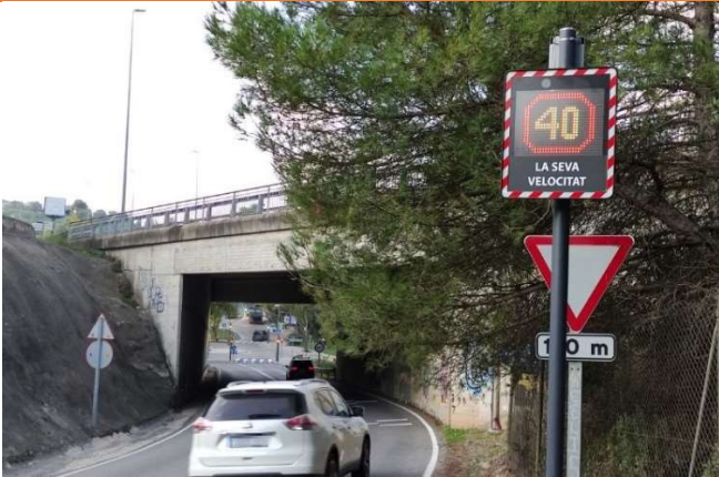
Instalación Radar en poste:
